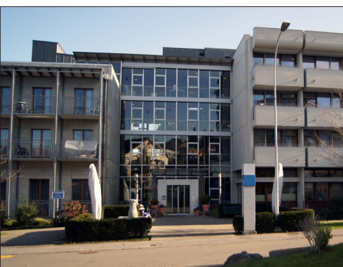
Der Eingangsbereich im Alters- und Pflegeheim Fahr wird erneuert
