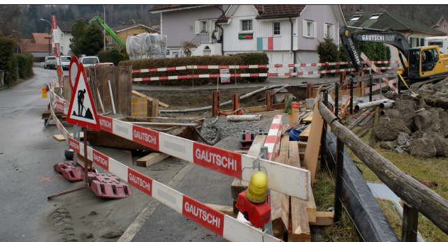
Ein Abschnitt der Dietrichshaldenstrasse muss aufgrund der Bauarbeiten umfahren werden
