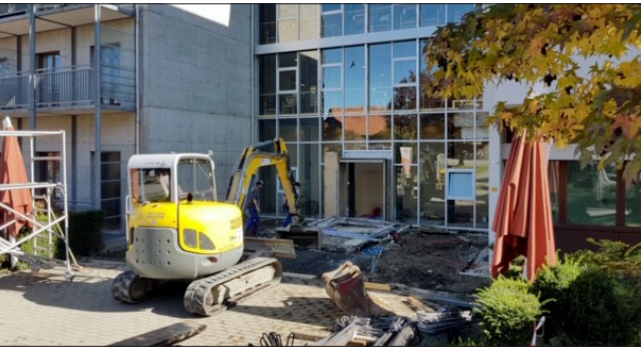
Der Umbau des Fahr-Eingangs ist oft etwas lärmig
