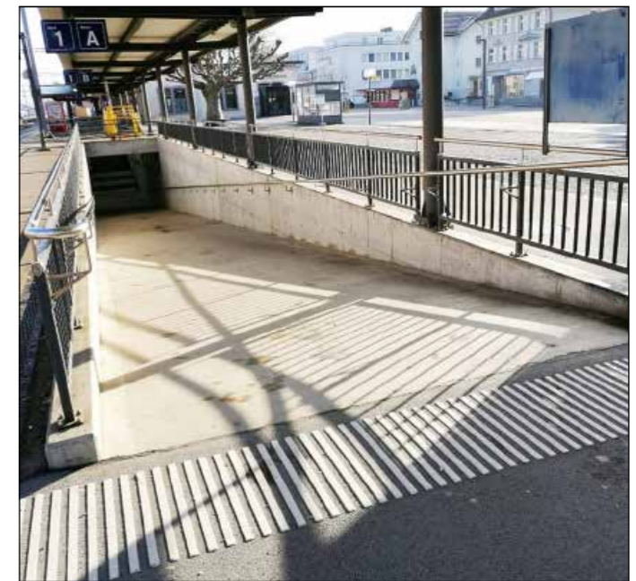
Rampe zur Unterführung am Bahnhof St. Margrethen.
