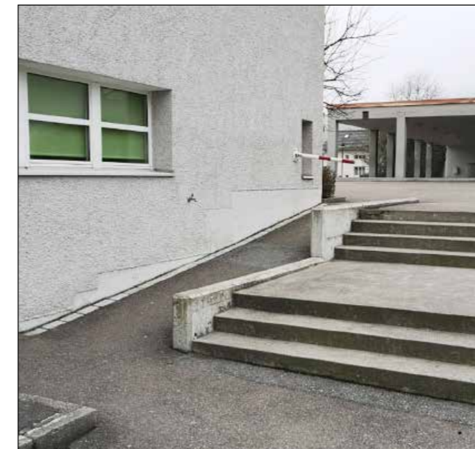
Rampe zum Schulhaus Wiesenau.
