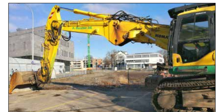
Das Areal vor Baubeginn.
