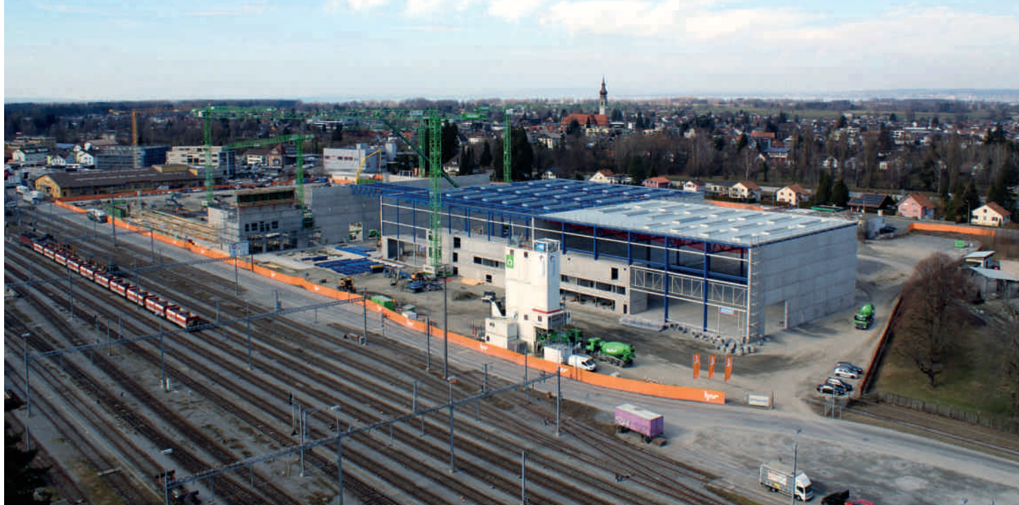
Im Schnelltempo wurde das neue Stadler-Werk in St. Margrethen erstellt
