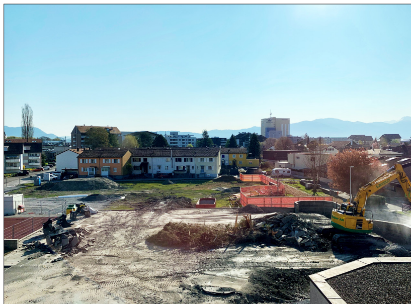
Bei strahlendem Frühlingswetter konnten die schweren Maschinen beim Schulhaus Wiesenau auf-fahren.
