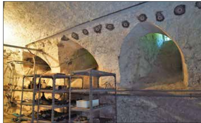
Bergstig. Aussenöffnungen unter eindrücklichen Stichkappen sorgen im gewölbten Wirtschaftskeller des 15. Jahrhunderts für eine gute Luftzirkulation. Aufnahme 2019, Johannes Huber, St. Gallen.
