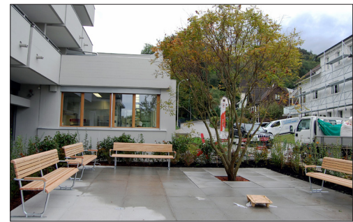
Der eben fertiggestellte Eingangsbereich wirkt einladender als der alte
