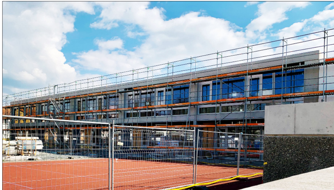
Der Innenausbau schreitet zügig voran. Das Baugerüst kann in Bälde entfernt werden
