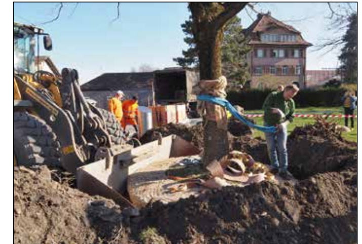
Die «neue» Linde wird sorgfältig in den Graben gesetzt.
