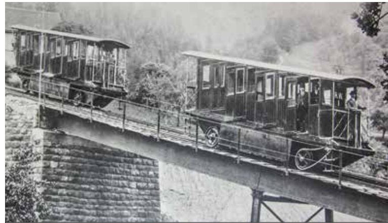
Drahtseilbahn Rheineck-Walzenhausen mit Wassertanks – 1947 führte extremer Wassermangel zur zeitweiligen Einstellung des Bahnbetriebs zwischen Ruderbach und Walzenhausen. Deutlich sind zwischen den Rädern der Wagen die Behälter für das Wasser zu erkennen.
