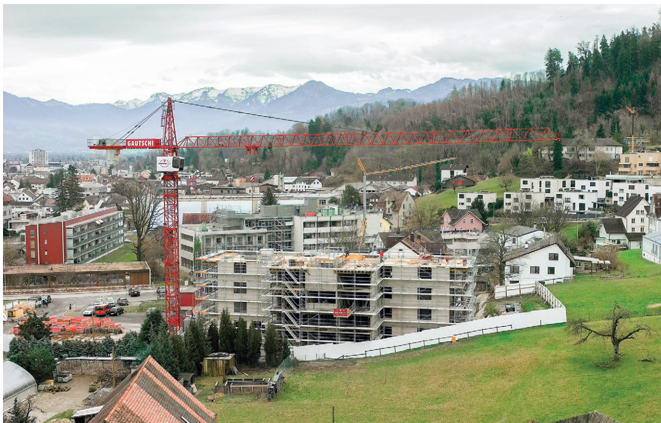
Der Erweiterungsbau Altersheim kommt gut voran; er wird 2025 bezogen.
