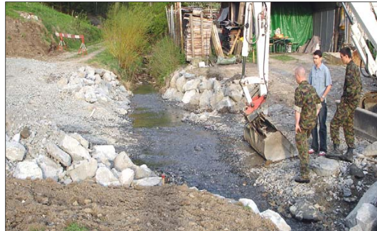
Der Wasenbach kann neu über eine Furt durchquert werden
