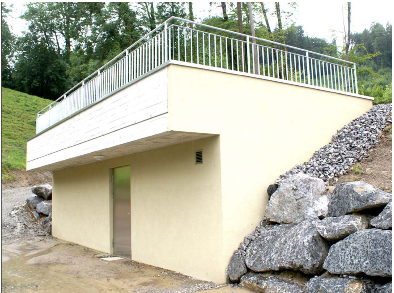
Der Neubau des Reservoir Käsgaden konnte der Wasserversorgung St. Margrethen im Mai 2009 anlässlich einer kleinen Feier übergeben werden
