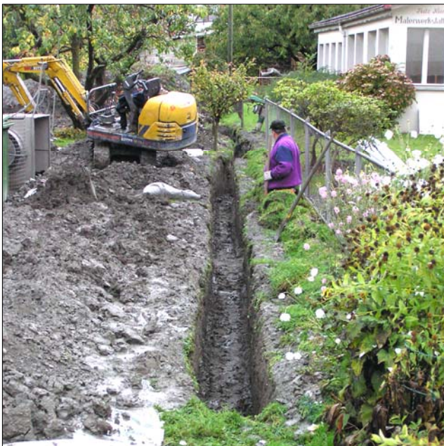
Der geöffnete Graben ist bereit für das Verlegen der Hausanschlussleitung
