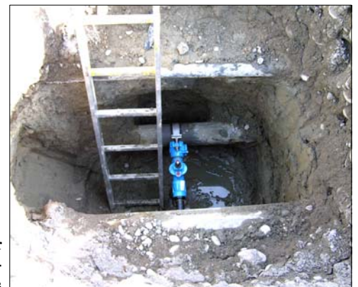
Installierter Hausanschluss
