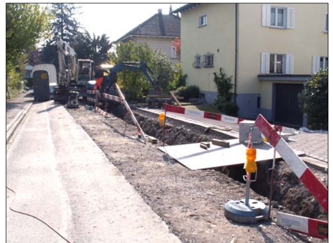
Mit dem Einbau des Deckbelags wird die Kanalsanierung Hörlisteg abgeschlossen
