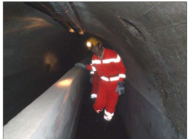
Routinekontrolle und Inspektion des Hörlistegkanals
