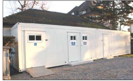
Neue WC-Anlage mit Materialraum
