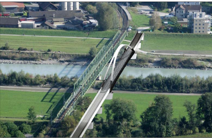
Im Herbst 2010 wird mit dem Bau der neuen ÖBB-Brücke begonnen
