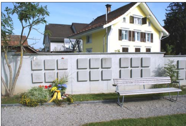
Die bestehende Urnenwand wird mit zusätzlichen Elementen erweitert
