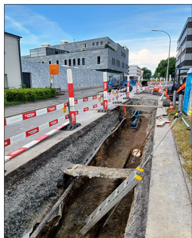
Das «Innenleben» einer Strasse erfordert grossen Aufwand
