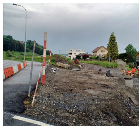
Wenn das Wetter mitspielt, sollte diese Baustelle noch vor Ende Jahr der Vergangenheit angehören
