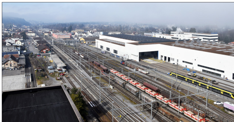
Das Werk bei uns ist wichtiger Teil des fast weltumspannenden Netzes von Stadler Rails Unternehmen
