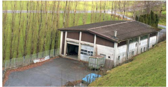
Der vorgesehene Werkhof am Mannenberg für das Bauamt und die Technischen Betriebe böte diverse Vorteile
