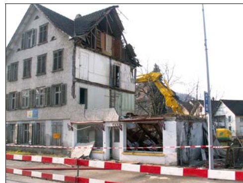
Nicht mehr sanierungswürdige Liegenschaften weichen künftigen Neubauten
