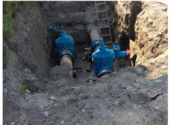
Zwei Schieber, welche den Wasserfluss durch die Transitleitungen steuern, wurden ersetzt
