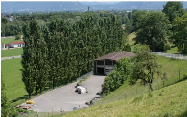
Im Gebiet Bächli entsteht der neue Werkhof
