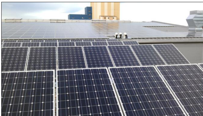
2011 realisierte die Buhmann AG eine 500 kW-Photovoltaikanlage auf dem Dach ihrer neuen Halle.
