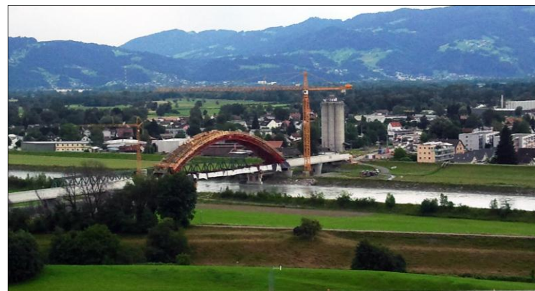
Inzwischen ist das rote Gerüst der Rheinbrücke abgebrochen
