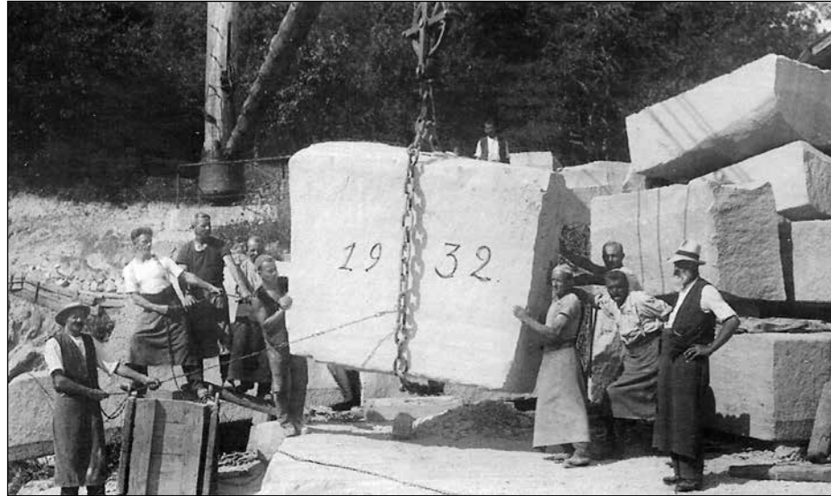
Ein Block wird mit einem einfachen Kran aus dem Steinbruch gehoben. Rechts mit Hut Gottlieb Gautschi.
