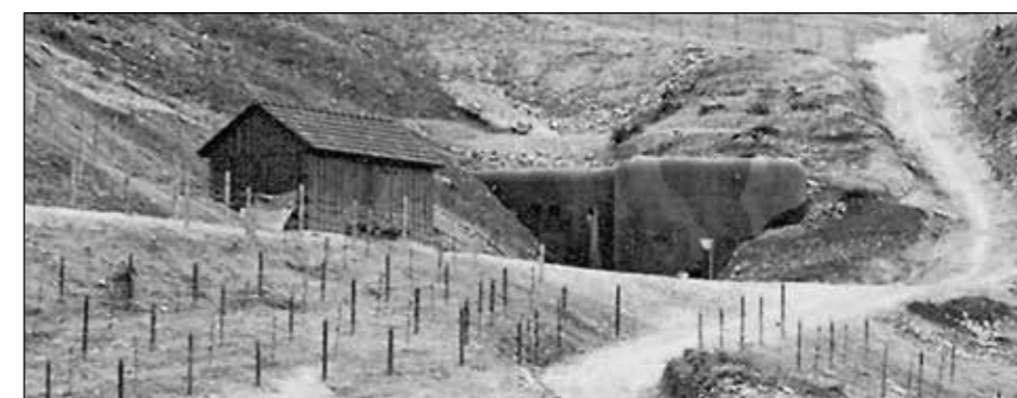
Festungsanlage Heldsberg um ca. 1943. Noch unbewaldet, mit Panzersperren, Haupteingang nicht getarnt.
