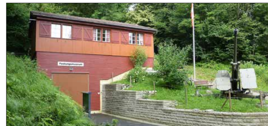
Bunker- Haupteingang mit orangem Tarnaufbau, während des Kalten Krieges erstellt. Integriert waren zugleich Büros der Festungswache.
