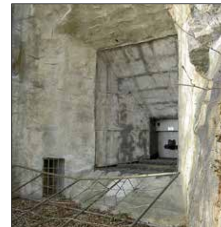
Schiesscharte einer der 7,5 cm Kanonen, Felscharte teils mit Gitternetz nachgebaut. Normal wurde über die Scharte ebenso ein Tarnvorhang hochgezogen. Dann verschwand die Scharte in der stets sichtbaren Felswand.
