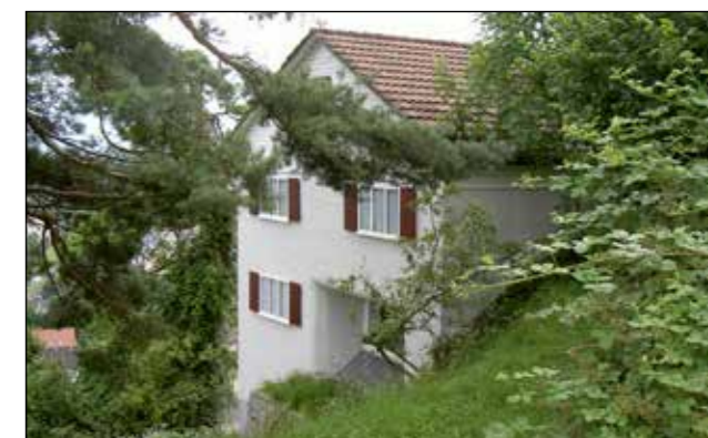
Maschinengewehrbunker am Südhang des Heldsbergs, als nettes Häuschen mit Fensterläden inkl. Vorhängen getarnt, auf der Südseite eine aufgemalte Eingangstüre.
