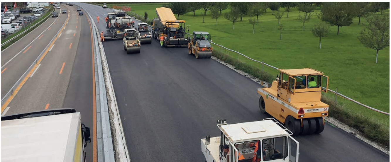
Erneuerung der Autobahn A1.
