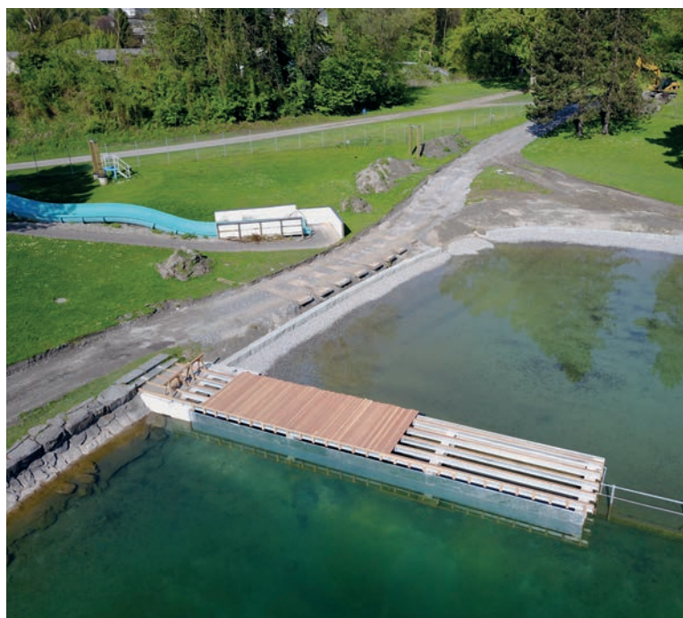
Sanierung der Badestege im Strandbad Bruggerhorn.
