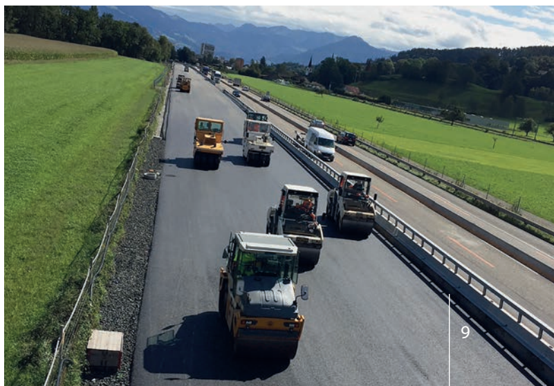
Belagsarbeiten auf der Autobahn A1.
