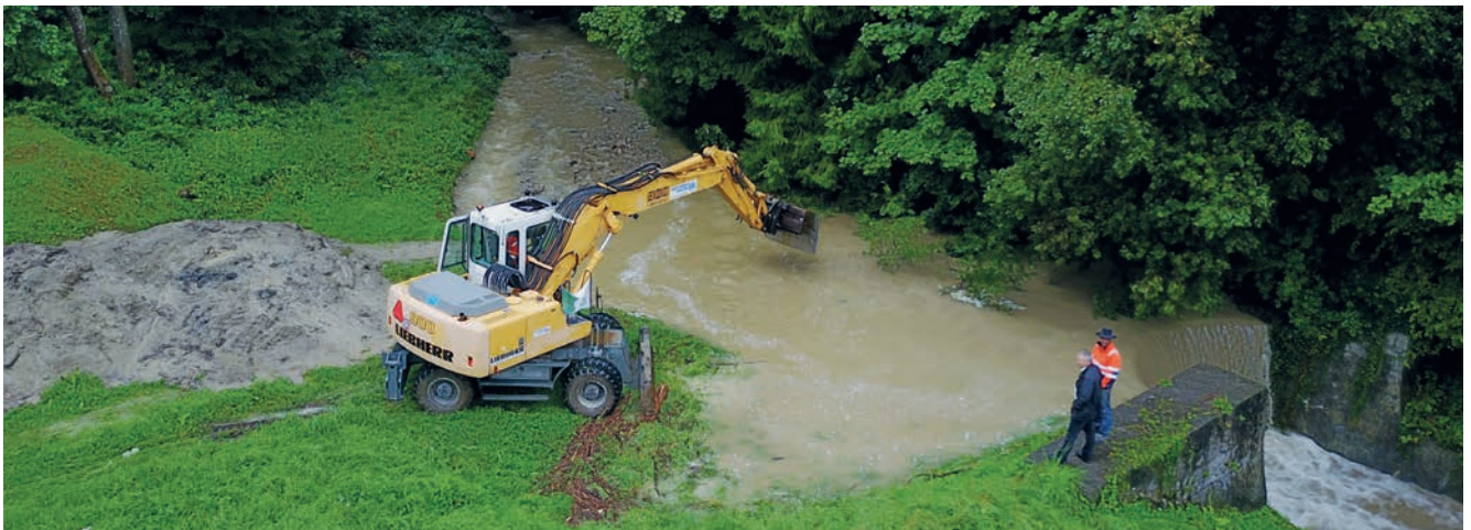
Ausbaggern eines Kiessammlers nach dem Hochwasser Anfang September.
