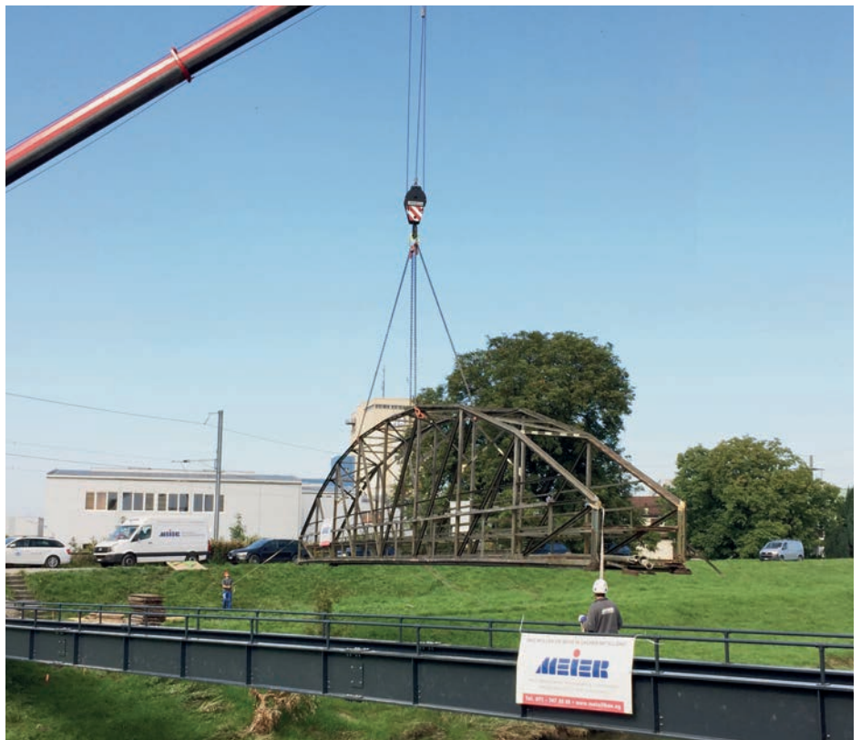
Neuer Dienststeg der Wasserversorgung über den Binnenkanal.
