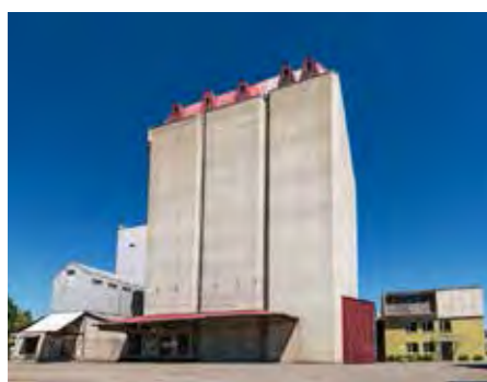
Markantes Wahrzeichen von St. Margrethen: Der Silo an der Industriestrasse 19.
