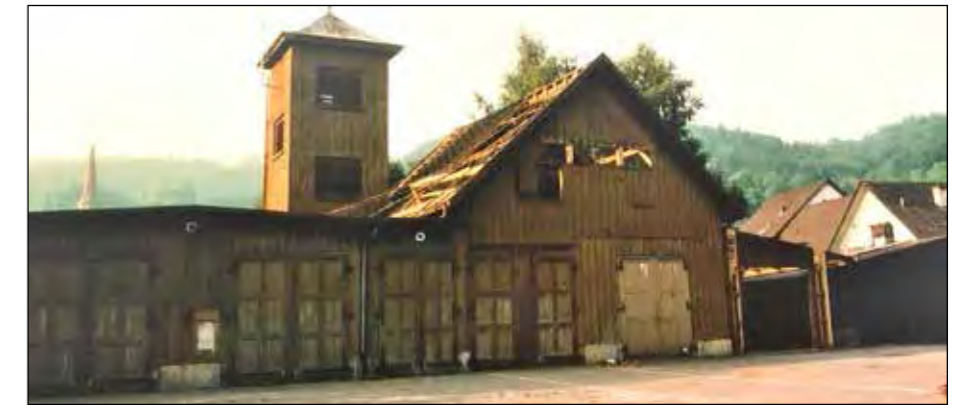
Altes Depot kurz vor dem Abbruch (Quelle: Feuerwehr St. Margrethen).
