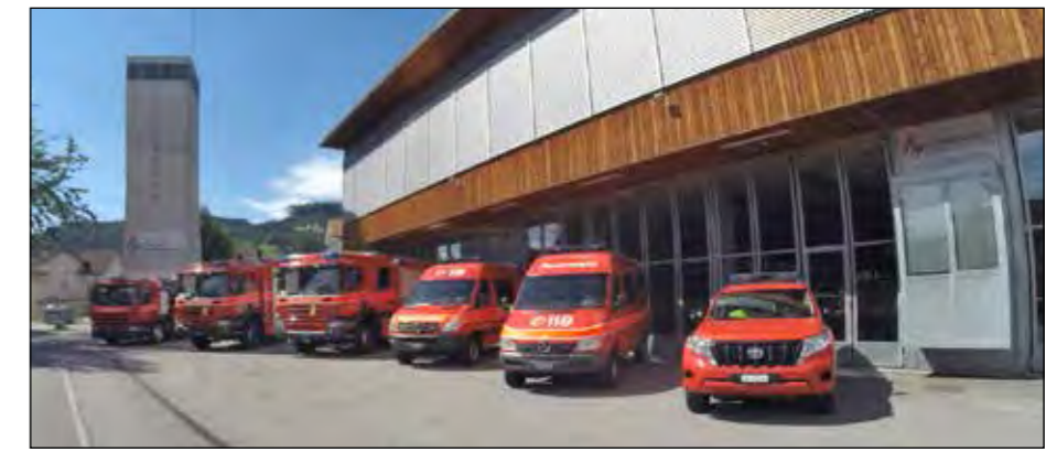
Feuerwehrdepot: Aussenansicht und Fuhrpark (Quelle: Feuerwehr St. Margrethen).
