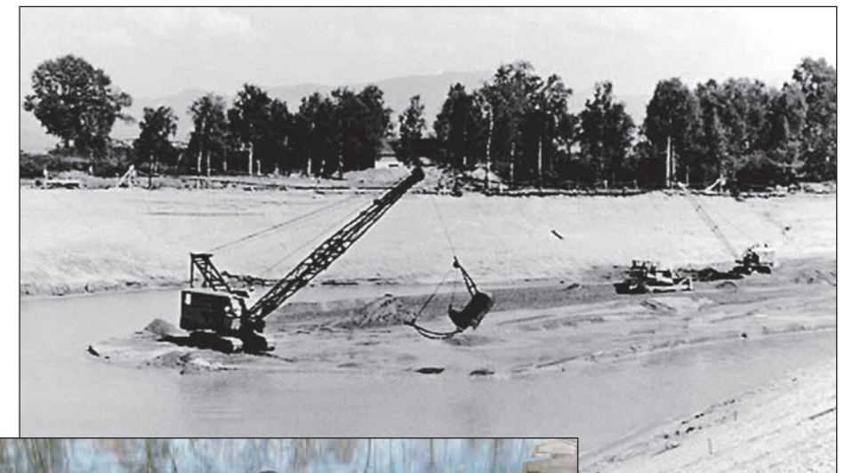
Aushebung des Weihers für den Bau der Autobahn anfangs 60er Jahre. (Quelle Guido Schneider)
