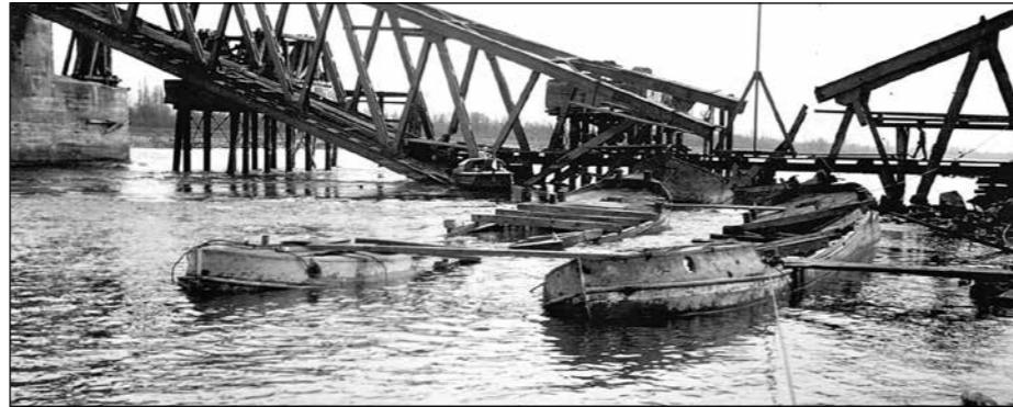
Versenkte Pontons und zerstörte Rheinbrücke bei Breisach.
